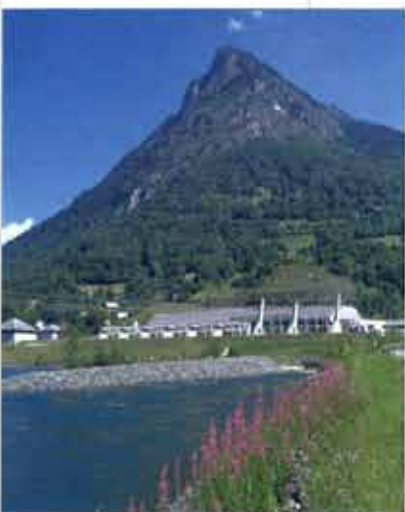
Centrale hydroélectrique de Grand'Maison (Isère)
