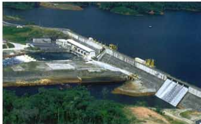
Barrage de Petit-Saut (Guyane)
