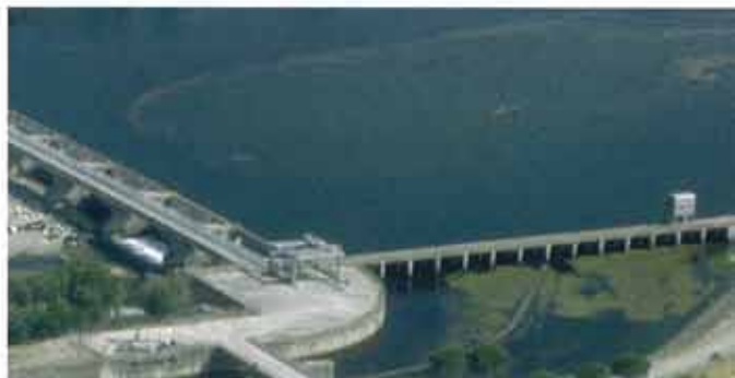
Canal d'amenée de l'usine hydraulique de Mallemort (Bouches-du-Rhône).
