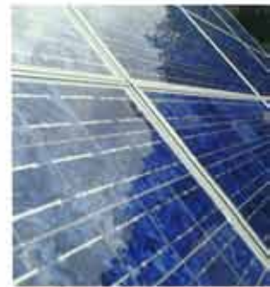
Les panneaux solaires photovoltaïques transforment directement l'énergie des photons du soleil en électricité.
