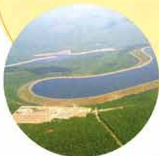
Station de pompage de Revin (Ardennes).
