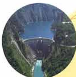
Barrage de Monteynard (Isère).
