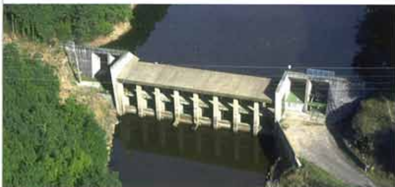
Barrage et retenue de Fleix sur la Vienne Supérieure (Haute Vienne)
