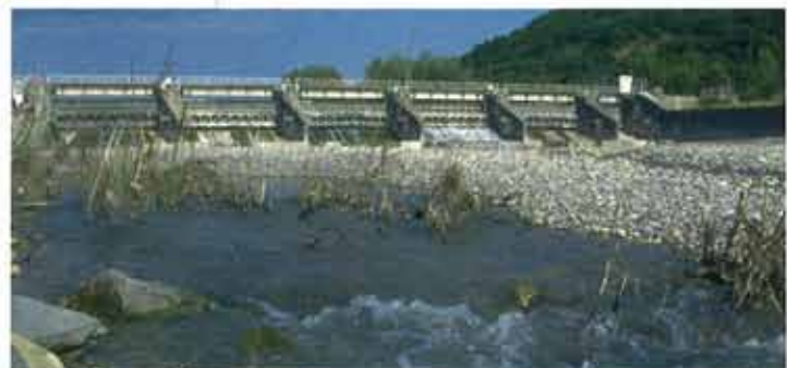
Barrage et retenue de Cadarache sur la Durance (Bouches-du-Rhône).
