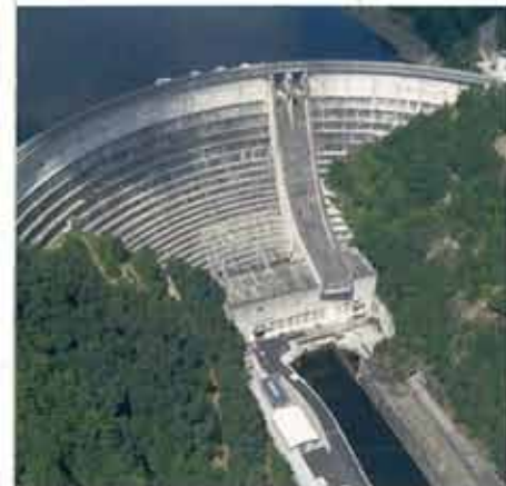
Barrage de Bort-les-Orgues (Corrèze)
