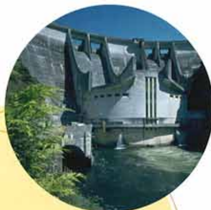
Barrage de l'Aigle (Cantal).
